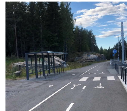
Valokuva Tampereen nykyisestä liityntäpyöräpysäköintikohteesta raitiotien varrelta. Vastaavaa katosmallia suositellaan käytettäväksi 1-3. luokan kohteissa.
